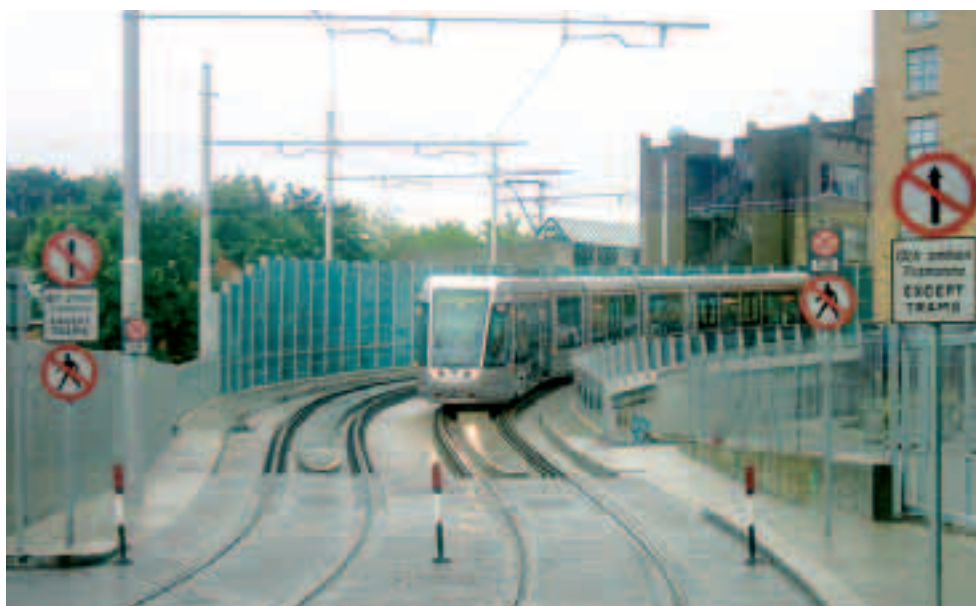
Stavba nové tramvajové tratě v irské metropoli byla pojata velkoryse, součástí je několik kolejových estakád či mostů. Na snímku opouští „zelená“ trasa centrum města a přechází z úrovně ulice na vlastní těleso.
