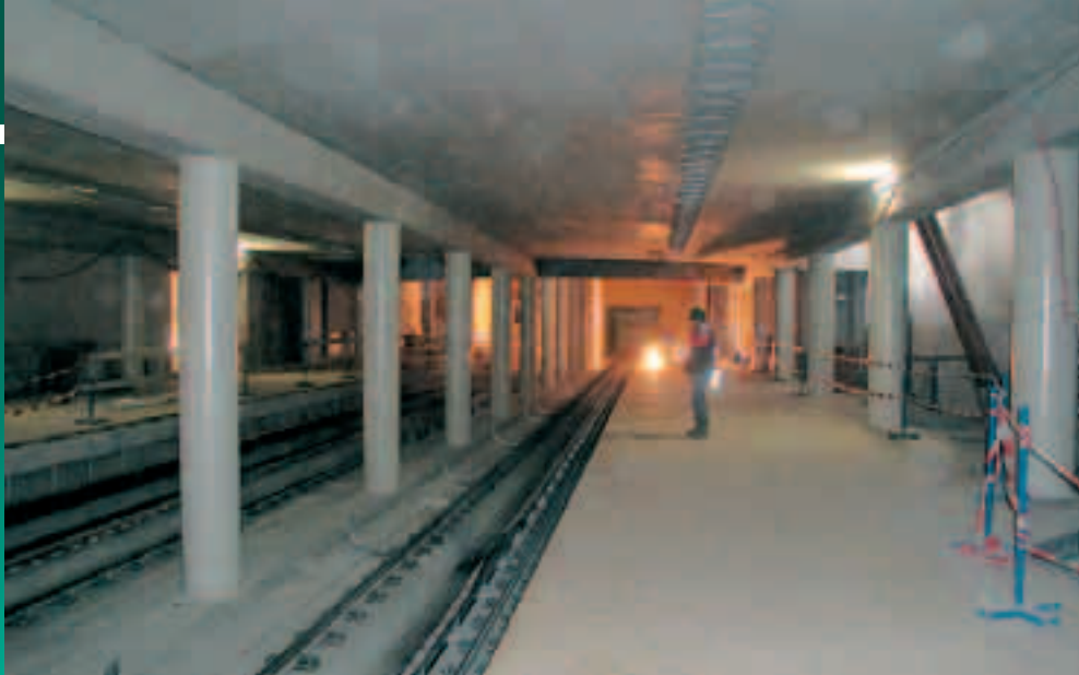
Stanice Prosek rok před otevřením – kolejiště se připravuje na montáž přívodní kolejnice.
