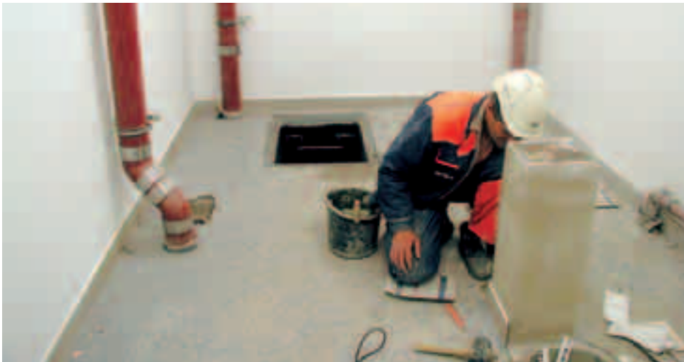
Dokončovací stavební úpravy před osazením technologie čerpací stanice. Jedné z 29 na IV.C2.
