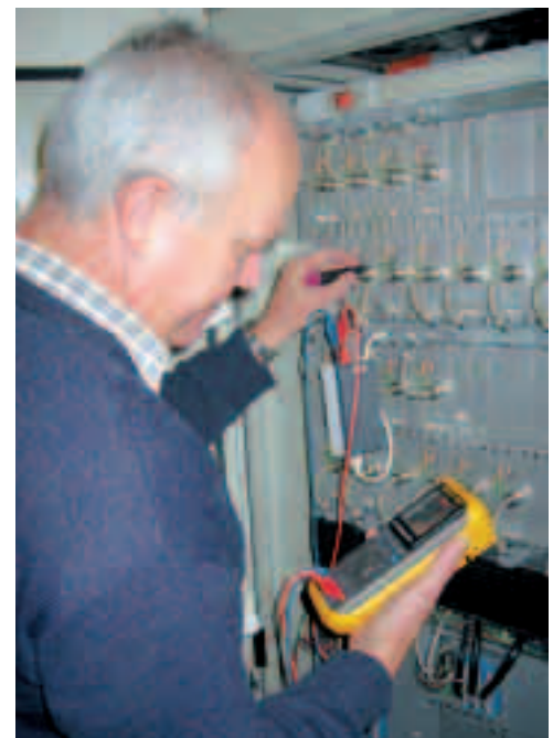
Nastavování výstupního zesilovače.
