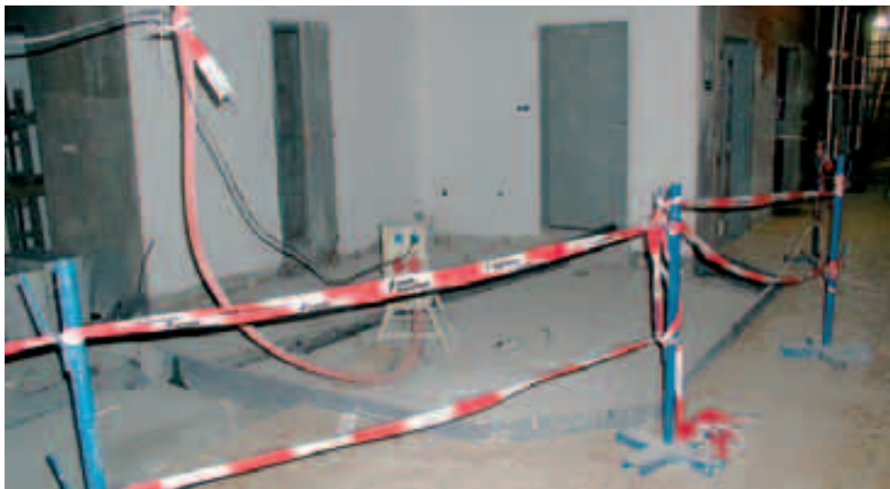
Představu o velikosti budoucího stanoviště přepravního manipulanta si můžeme udělat jen podle základů na uchycení budoucí skleněné konstrukce.
