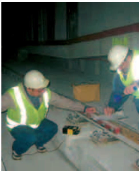
Měření izolačního stavu.
