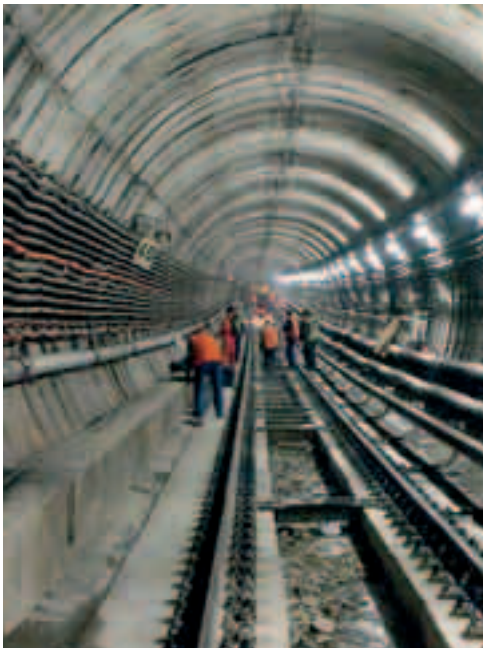
Sanace kolejového svršku na trati B.
