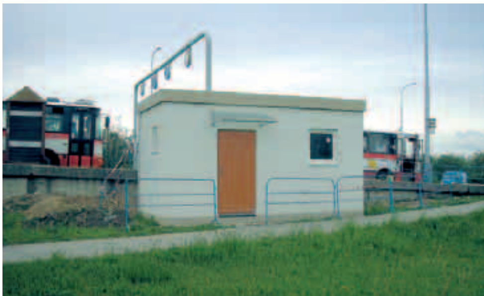
Sociální zařízení na konečné zastávce Opatov.
