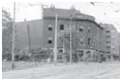
To je pohled na stejný dům od severu. Závory ještě existují (ale už se neužívají), železniční koleje v ulici Na Žertvách zarůstají trávou.
