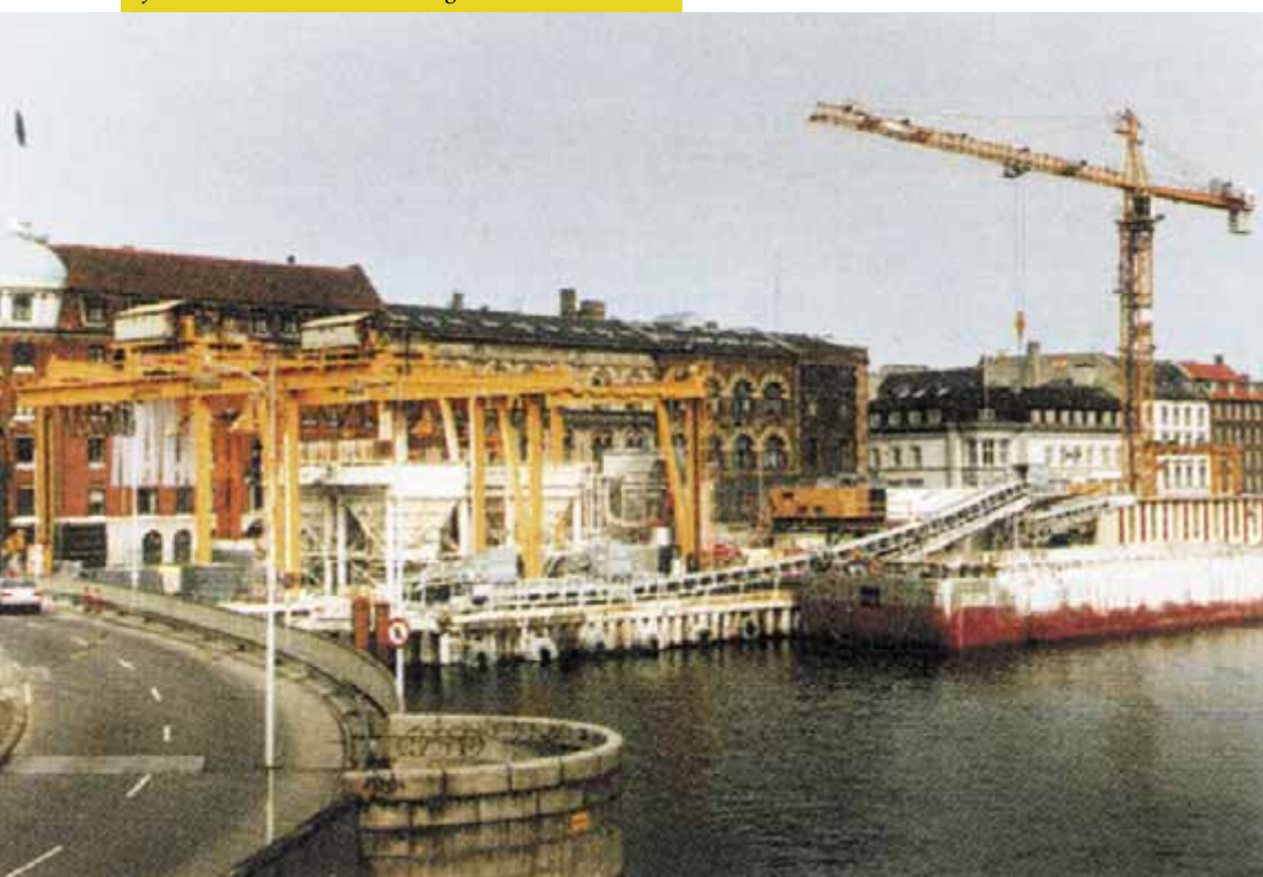
Bývalé hlavní stavenišť Havnegade.
