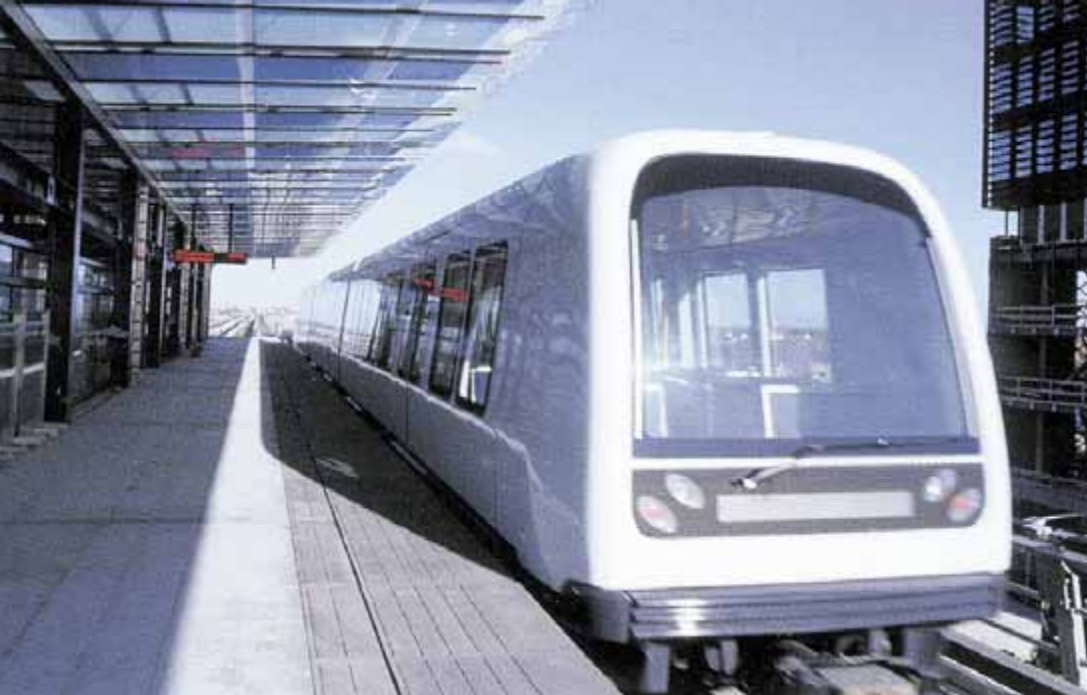
Souprava v nadzemní stanici.
