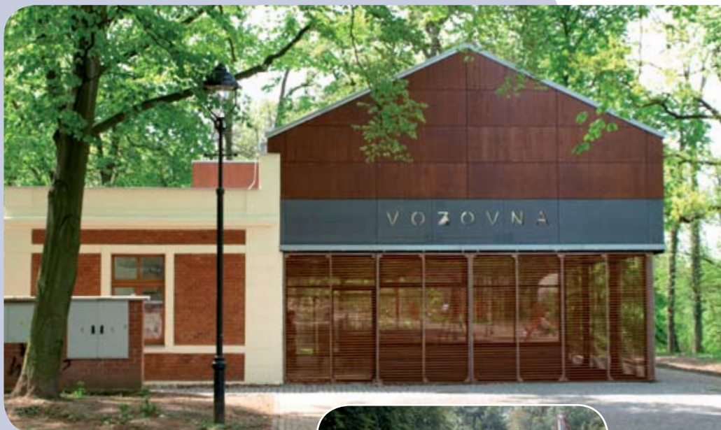
Bývalá vozovna v Královské oboře na sklonku dubna 2008. Žaluziové stěny jsou částečně posuvné, takže prostor po otevření občerstvení bude proměnlivý.
