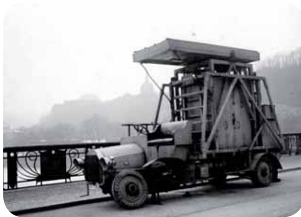
↑ Toto je někdejší autobus Fiat přestavěný k nepoznání. Jak je na snímku vidět, poruchy se mu nevyhýbaly ani v době, kdy sloužil jako montážní vůz pro opravy trolejového vedení.
