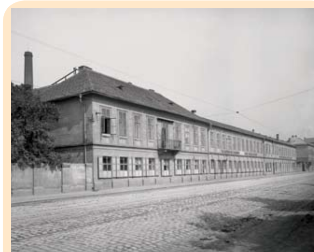
↑ A to je pohled na ředitelskou budovu od dnešní Sokolovské ulice kolem roku 1923. Tehdy ještě měla o něco vyšší střechu, balkon a mnohem zdobenější fasádu.
