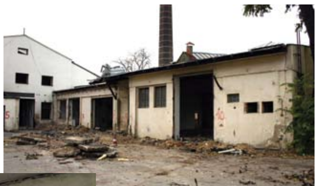
↑ Tuto budovu mnozí pamatují jako tzv. autodílnu, ale opravovaly se tu i autobusy. Ostatně – byla to první pražská autobusová garáž, postavená ve dvou etapách v letech 1924–1925. Fotografie je z 22. října 2007. Demolice proběhla na přelomu ledna a února letošního roku.
