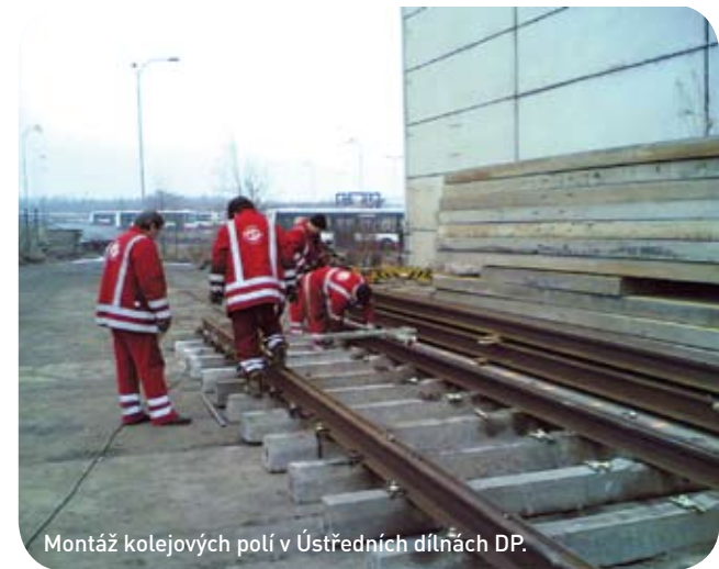
Kolejová pole pro opravu tramvajové trati jsou již připravena.
