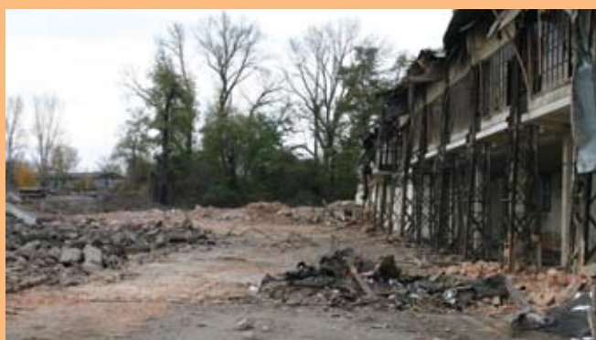
↓ A ještě jednou strojovna montovny tramvají, tentokrát 2. listopadu 2007, kdy z ní zbývala jen krajní loď podél ulice Švábky. Její zboření definitivně začalo dávat zcela nový ráz celému okolí Rustonky.
