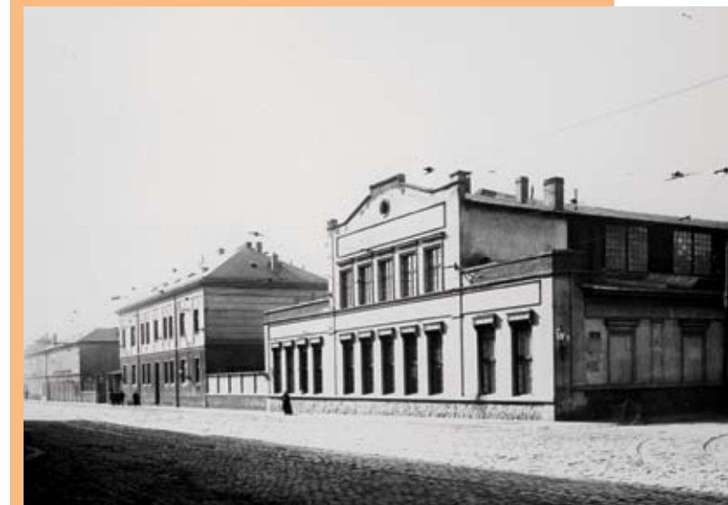
↑ Nároží dnešní Sokolovské a Švábků kolem roku 1923. Nárožní budova patří k bývalé mostárně, která byla Elektrickými podniky adaptována na montovnu ústředních dílen tramvají . V roce 1925 byly v krajní části přistavěny kanceláře a celý štít dostal novou podobu.
