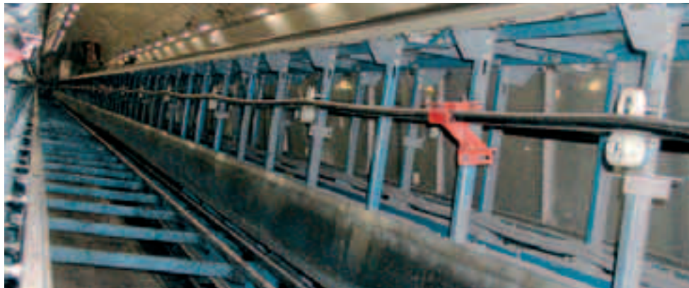
Eskalátor ve stanici Hradčanská je jeden z prvních „nových“ eskalátorů, který je v generální opravě. Je ještě potřeba osadit tažný řetěz se schodovým pásmem a eskalátor zakrýt balustrádou.
