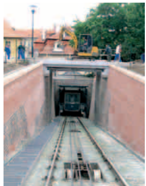
Pohled na rekonstruované zárubní zdi a most nad dolní stanicí lanovky.
