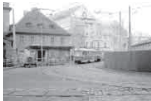
Na tomto snímku jede tramvaj v roce 1983 na prvním, ještě dvoukolejném provizoriu, postaveném při stavbě stanice metra.
