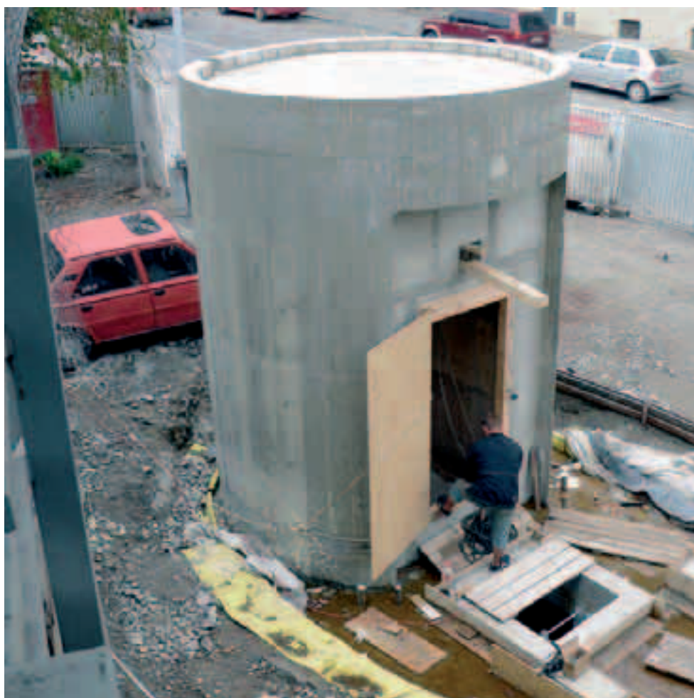
Výtah ve stanici Florenc B, povrchový kiosky – hrubá stavba.
