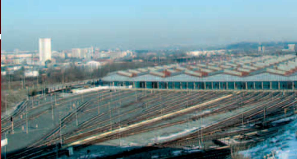
Při pohledu na zhlaví depa je dobře viditelná narovnaná 1. a 2. staniční kolej. Přes ně se dozadu zajíždí na zkušební kolej. Samotná stanice nezabírá ani desetinu haly B.
