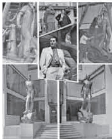
Reportáž na třetí straně obálky Elektrické služby 6-7 z roku 1938 zachytila instalaci Ducháčkových soch.
