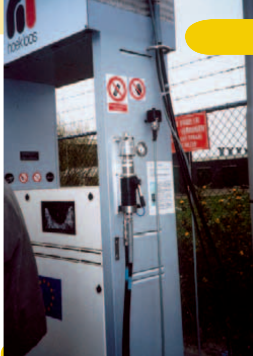
Detail plnicí hlavice a uzemnění.
