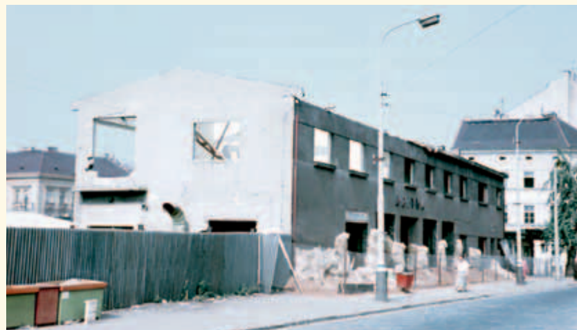
V době, kdy první traťový úsek pražského metra zahájil provoz, se už stavěla i trať A. Alespoň čtyřmi fotografiemi si připomeňme, jak začínala tato kapitola stavby století. V minulosti jsme už na našich stránkách přinesli fotografie z oblasti dnešní stanice Hradčanská. Snímkem z 14. července 1973 chceme připomenout tzv. Dům Aritmy, který stával vlevo od závor, těsně před zbořením.
