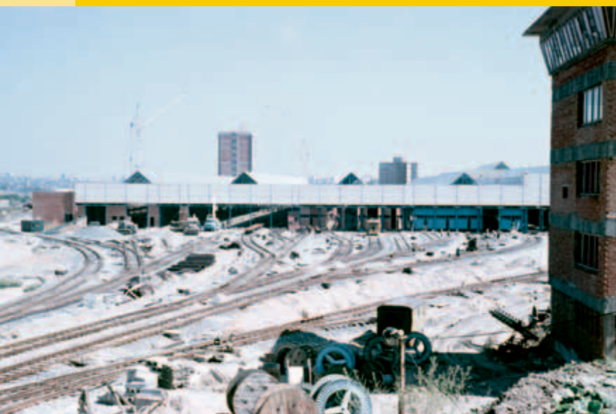
Depo metra 6. srpna 1973. Zhruba za dva měsíce přivítá prvních šest vagonů typu Ečs...
