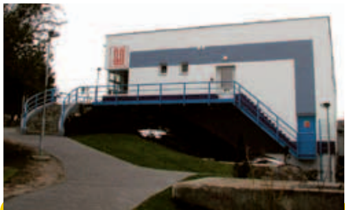
Pohled na objekt ze směru příchodu do depa Kačerov. Vestavěná prosklená vrátnice je na levé straně v rohu budovy.
