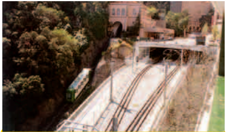
Pohled na koncovou stanici ozubnicové dráhy a lanovku Santa Cova.
