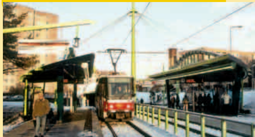
Stanice Poliklinika Barrandov v polovině prosince.
