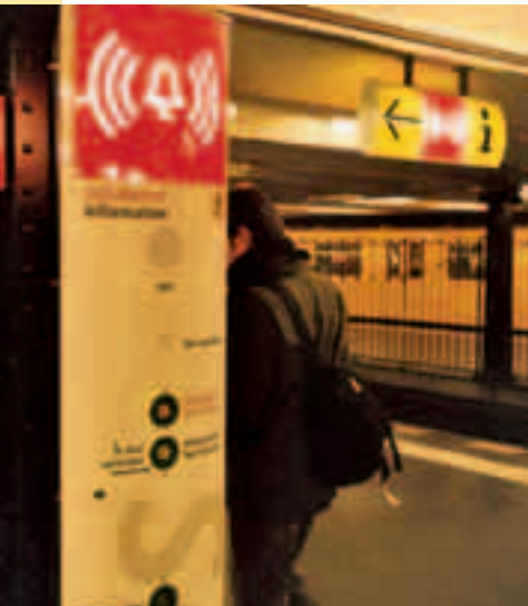
Sloupky nouzového volání a informování na nástupištích všech 170 stanic metra: zprostředkovávají informace a lze z nich i tísňově volat. Sloupky jsou přístupné pro vozíčkáře.
