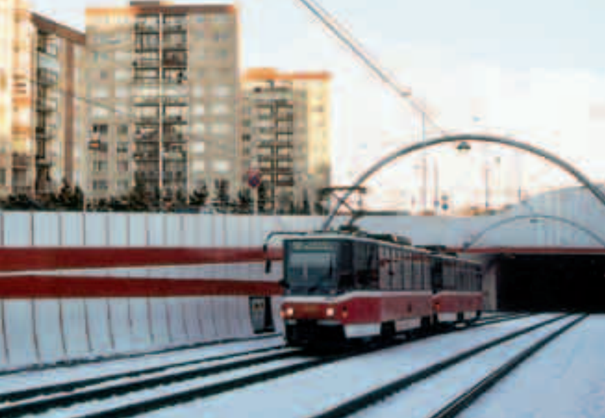
Tramvajová trať je novou dominantou barrandovského sídliště.
