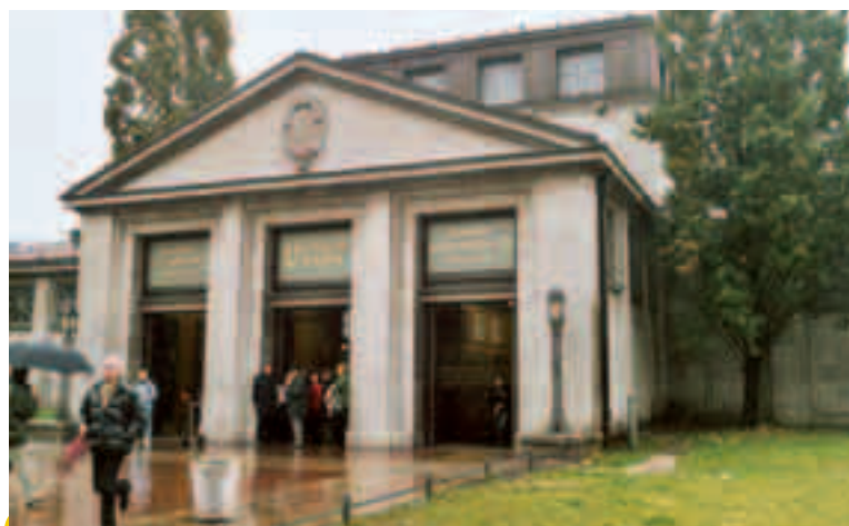
Nově rekonstruovaná stanice metra Wittenbergplatz: konečná stanice západní části linky U2 do roku 1993.
