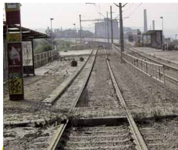
Zastávka Nádraží Modřany po povodni v neděli 18. srpna 2002. Foto: Petr Mašek
