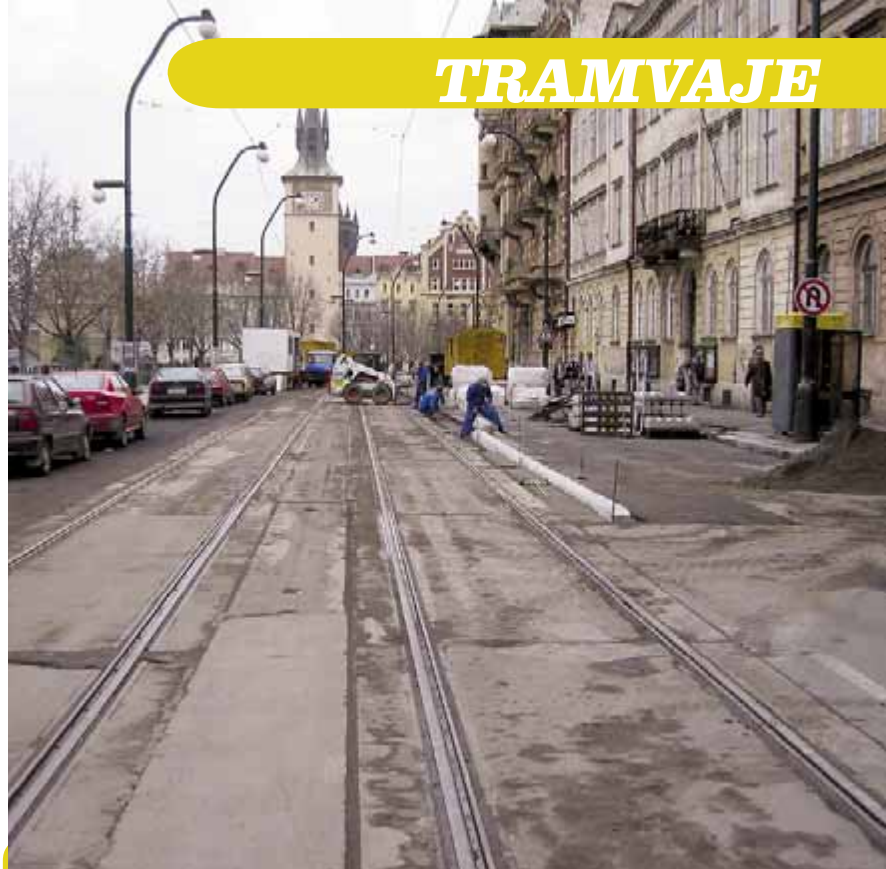
Osazování betonových dělicích proků na Smetanově nábřeží - 4. listopadu 2002.
