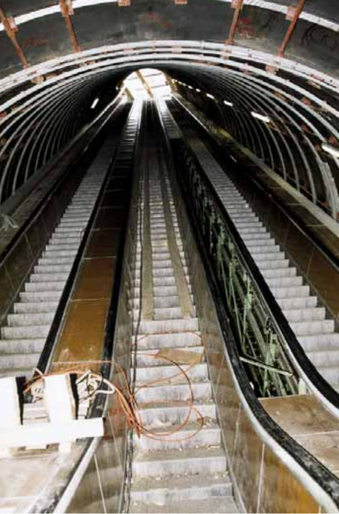
Eskalátorový tunel ve stanici Invalidovna, prostřední schodiště slouží k dopravě materiálu na nástupiště.
