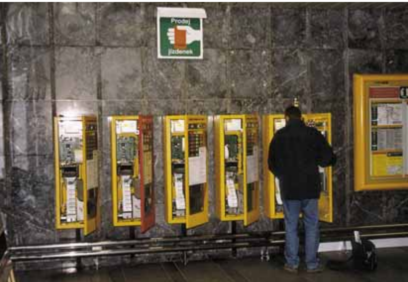
Na příchod cestujících je třeba připravit i jízdenkové automaty. Malostranská je stanicí s častým výskytem cizinců, a tak všechno musí být v pořádku.
