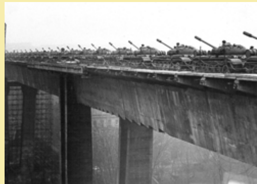
Tak vypadal Nuselský most při statické zatěžkávací zkoušce pomocí tanků 27. listopadu 1970.
