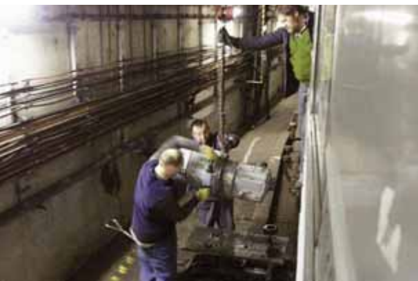
Výměna kompresoru u jedné ze souprav trvale působících ve stanici Černý Most.
