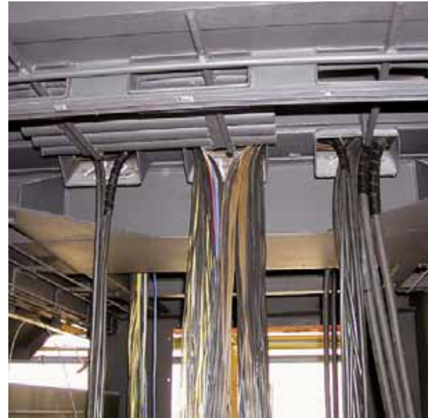
Příprava kabeláže pro připojení kontejnerů.
