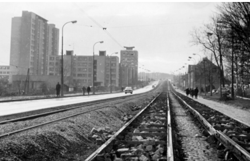
Pohled od někdejší Kladenské třídy od mostu přes Libocký potok směrem k vokovické vozovně 29. ledna 1967. V té době byla zahájena likvidace původních kolejí a jezdilo se zde obousměrně po jedné nové koleji. Foto: Jiří Čermák
