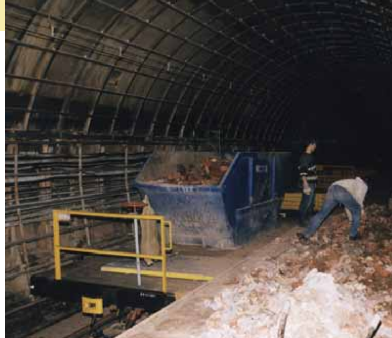
↑↓ Na obnově se pracuje intenzivně jak na „áčku“, tak na „béčku“.
