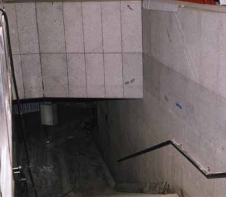
Další zastávkou byla stanice Nádraží Holešovice. Modrá ryska nad schodištěm od nádraží ukazuje, kam při kulminaci vystoupila hladina Vltavy.
