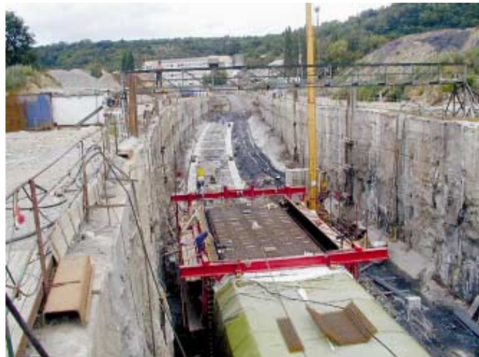
Betonáž segmentu traťového tunelu připravovaného k vysunutí do řeky (přechod Vltavy na trase IV. CI).
