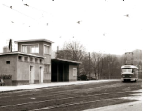
Tak vypadala nástupní zastávka smyčky Hlubočepy v roce 1964: čekárna, záchody a příležitostně dispečerské stánoviště, ze kterého byl výhled i na autobusovou konečnou „za trať“. Foto: sbírka autora
