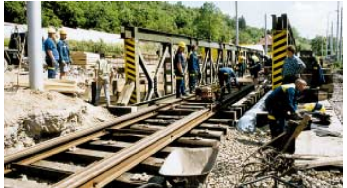
Stavba metra si vyžádala i jízdu tramvají po kolejové splítkě v Trojské ulici.
