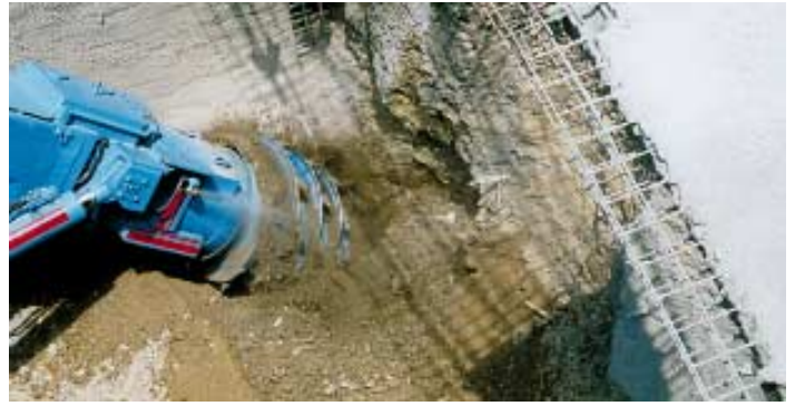
Ražba na IV. provozním úseku tratě C1 začíná!
