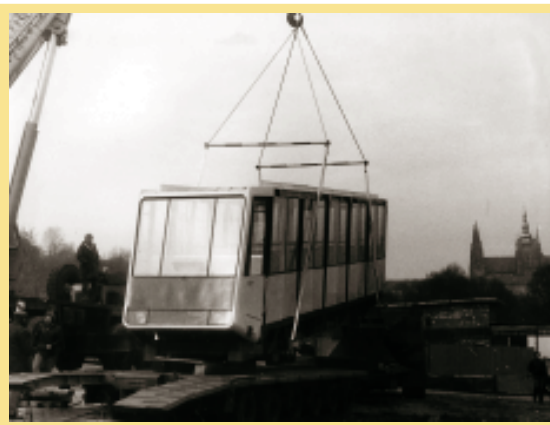
Dne 8. února 1985 se na koleje petřínské lanovky opět ukládaly nové vozy. Tentokrát se nekladla provizorní kolej, ale pomáhaly výkonné jeřáby. Vozy vyrobila Vagónka Studénka.
