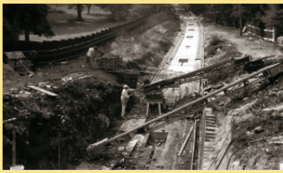
Obnova traťového tělesa v dolní části tratě. Foto: Archiv DP
